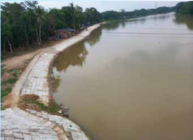
নদীতীর সংরক্ষণ, হালদা নদীর বাম তীরে বড়ুয়া পাড়া, রাউজান, চট্টগ্রাম
