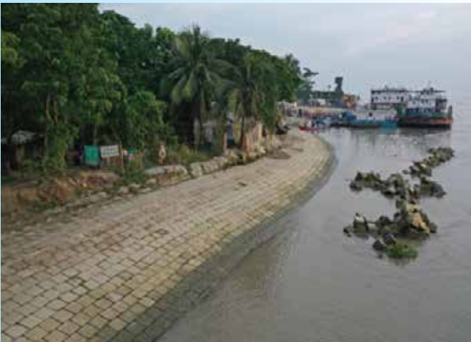
নদীতীর সংরক্ষণ, মেঘনা নদী, হরিণা, চাঁদপুর সদর, চাঁদপুর
