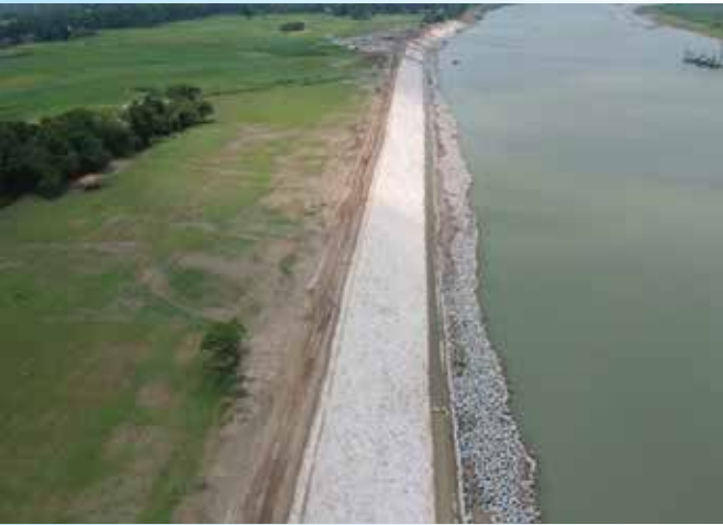
নদীতীর সংরক্ষণ, এমপিডাঙ্গী এলাকা, চরভদ্রাসন, ফরিদপুর
