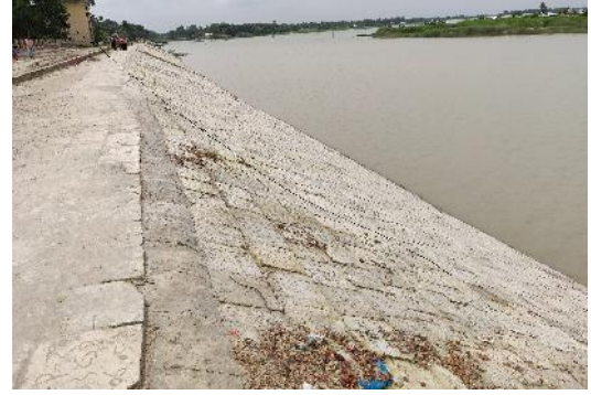
জামালপুর শহর সংরক্ষণ প্রকল্পের আওতাভুক্ত তীর সংরক্ষণ কাজের ডাম্পিং জোন শক্তিশালীকরণ প্রকল্প প্রতিরক্ষা কাজ
