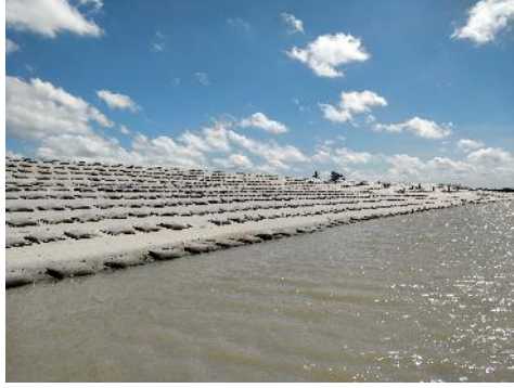
জামালপুর শহর সংরক্ষণ প্রকল্পের আওতাভুক্ত তীর সংরক্ষণ কাজের ডাম্পিং জোন শক্তিশালীকরণ প্রকল্প প্রতিরক্ষা কাজ
