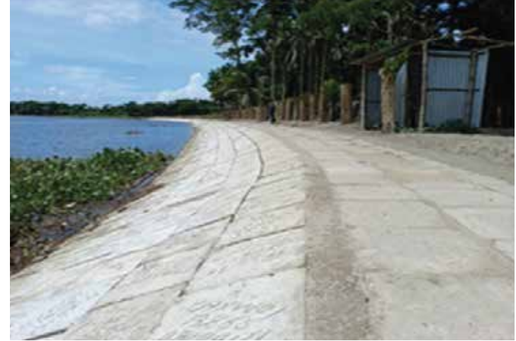
রহমতখালী খালের ডান তীর সংরক্ষণ, লক্ষীপুর
