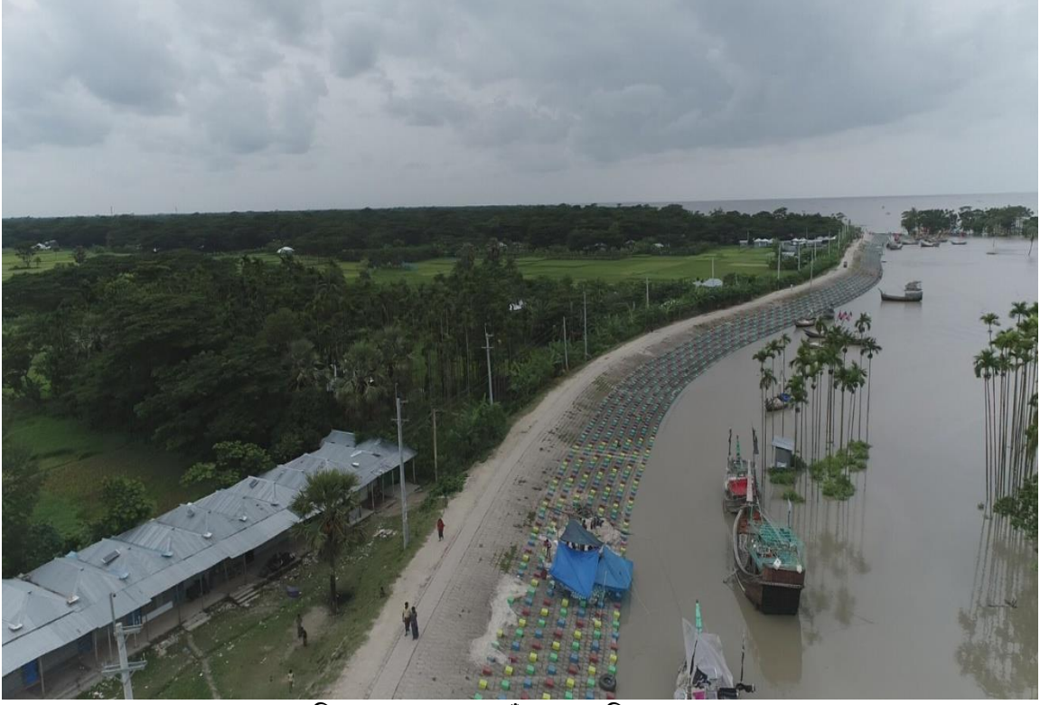
চিত্র: ঢাল সংরক্ষণসহ বাঁধ পুনরাকৃতিকরণ কাজ।
